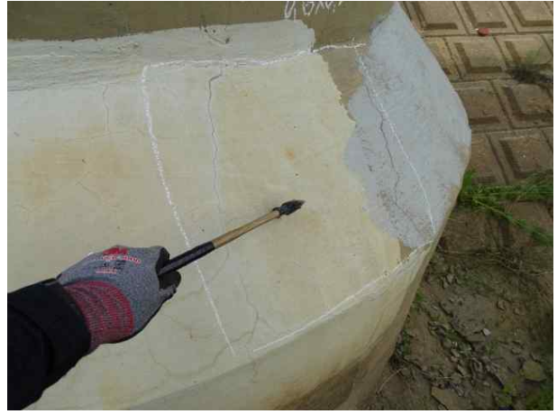
점검망치를 이용한 외관조사
