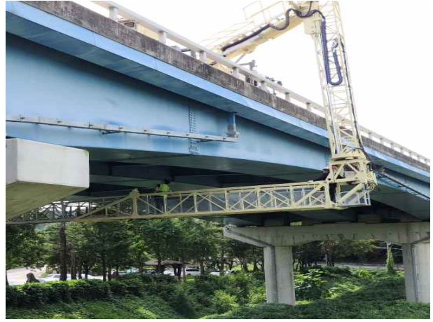
교량점검차를 이용한 외관조사
