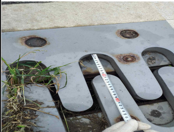
신축이음 유간거리 측정
