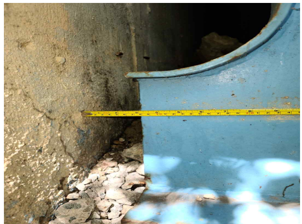
거더 유간 측정
