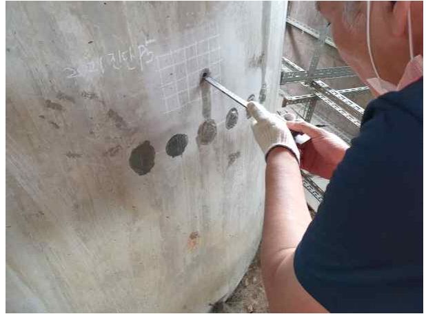
탄산화 깊이 측정
