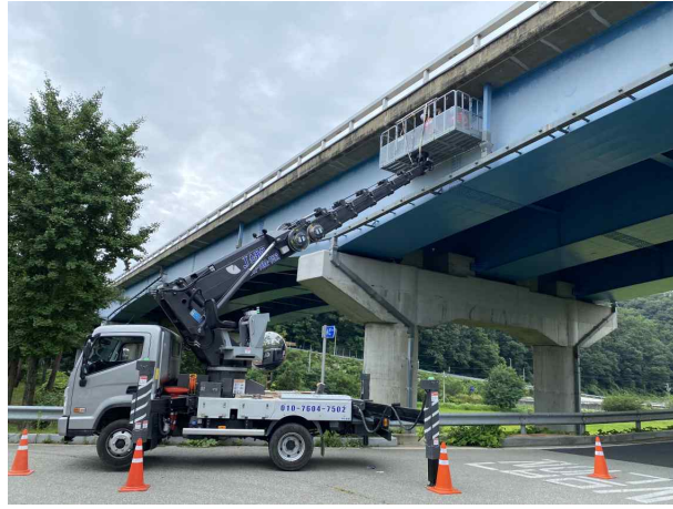
도보를 이용한 외관조사
