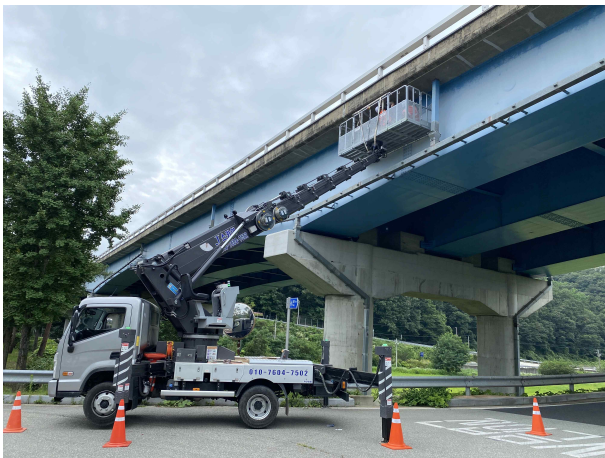
고소작업차를 이용한 외관조사
