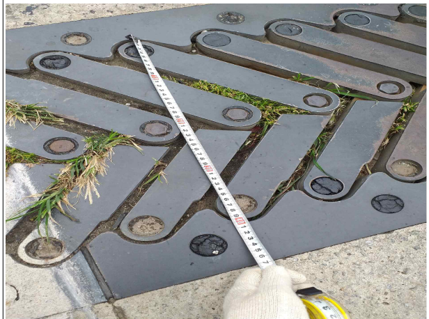
신축이음 유간거리 측정
